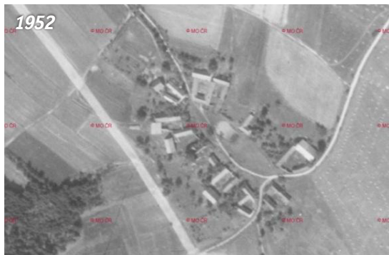
Podoba centra sídla před celkovou demolicí
