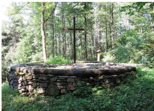
Obnovené základy kaple
