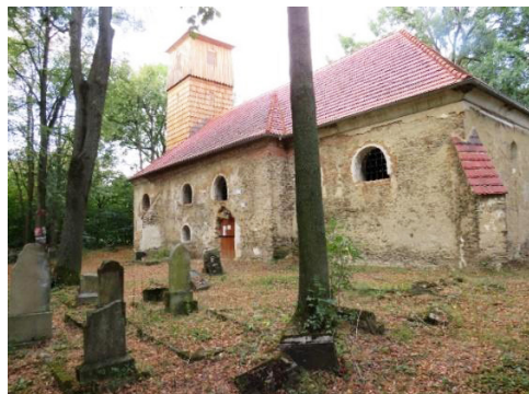
Opravený kostel sv. Jiří
