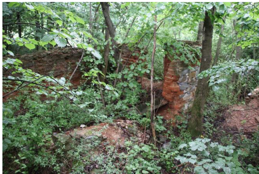
Rozvaliny původní zástavby
